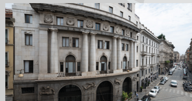
Via Santa Margherita 12, Milano 2017 Progettista / architect : Asti Architetti - Milano
