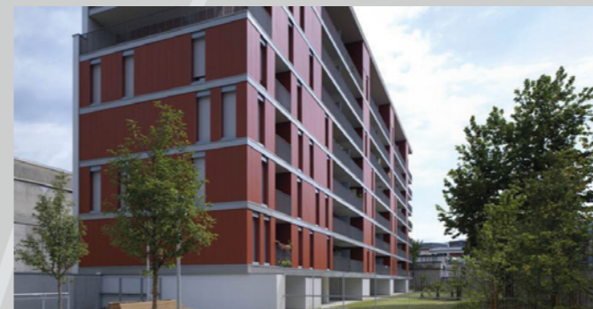
Via Pitteri 106, Milano 2015 Progettista / architect : SBG Architetti - Milano
