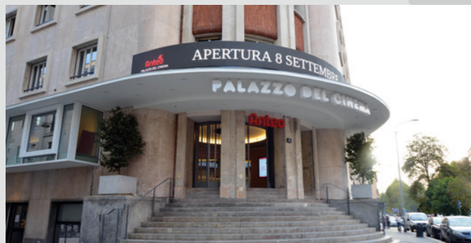
Piazza XXV Aprile 8, Milano 2017 Progettista / architect : Riccardo Rocco Architetto - Milano
